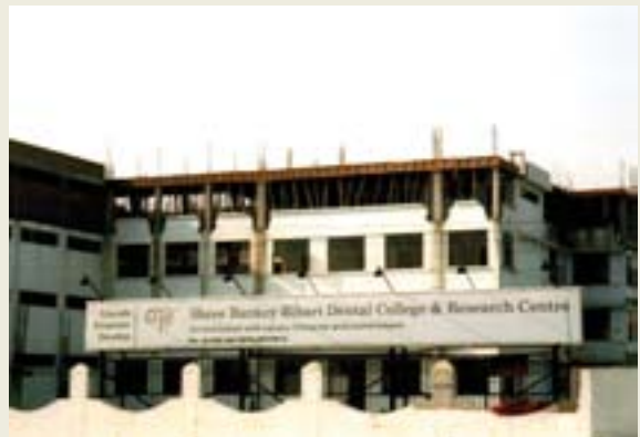
本事業実施後、沿線に建設中の歯科短大
