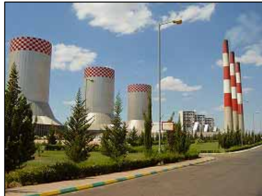
アル・ザラ火力発電所
