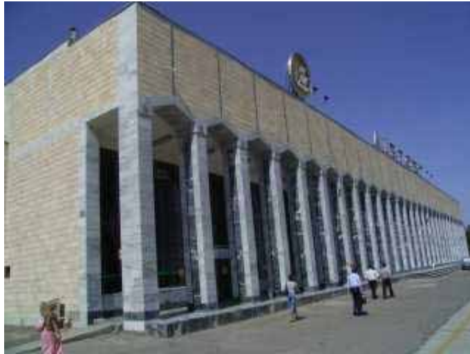
(修復されたサマルカンド空港のターミナル)
