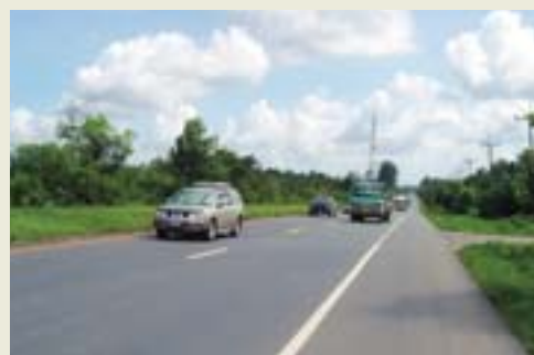
本事業により拡幅整備された国道
