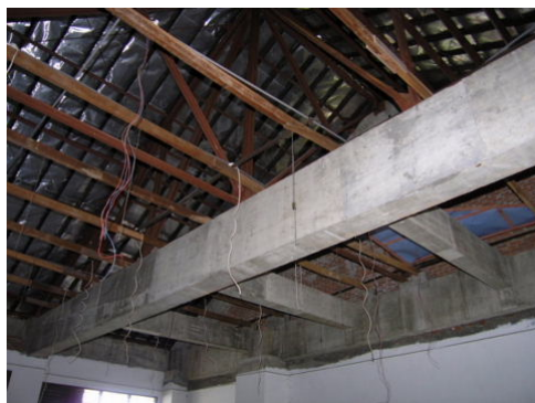
工学部校舎3階の天井
