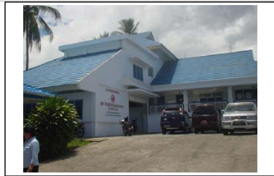
本事業で建設された血液センター
