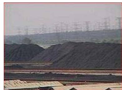
図 7 発電所の貯炭所
