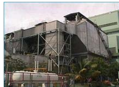
図 13 本事業で設置した石炭灰集積所
