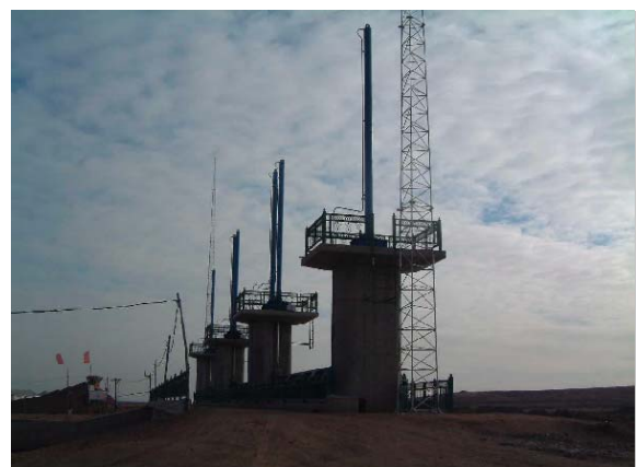
撓力河下流域に建設された頭首工
