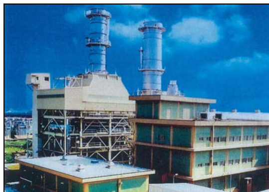
本事業で建設された発電設備
