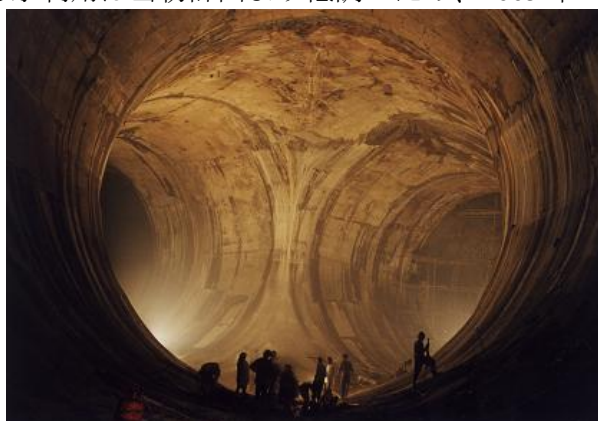
取水トンネルの分岐点
