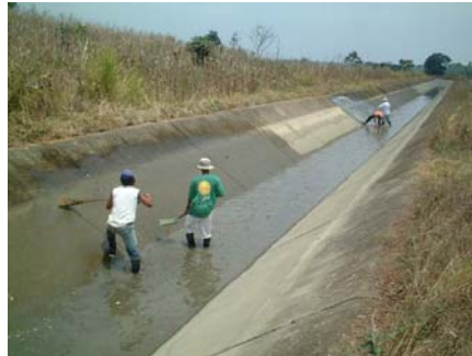
図 3 水路の清掃作業
