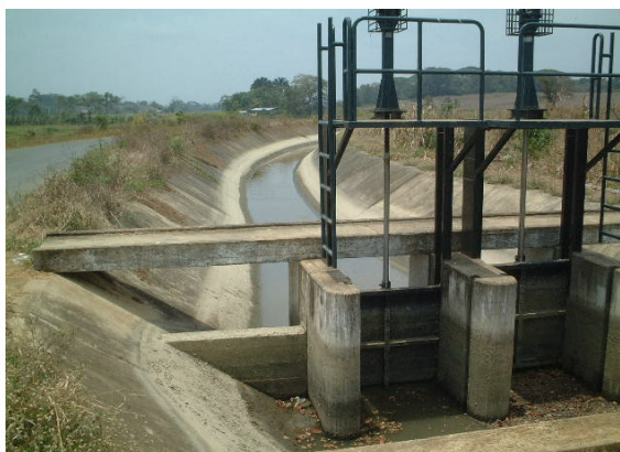
本事業で整備された二次水路
