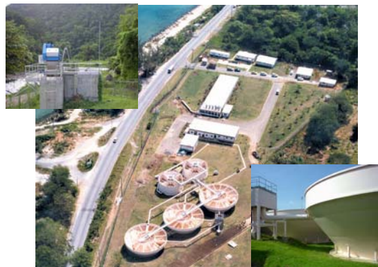
(左から) 取水施設、浄水施設全景、沈殿池
