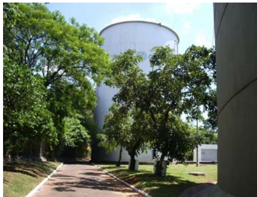
K m 2 配水センターの高架タンク
