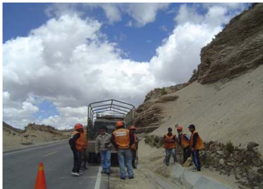
図-9 日常メンテナンス作業
