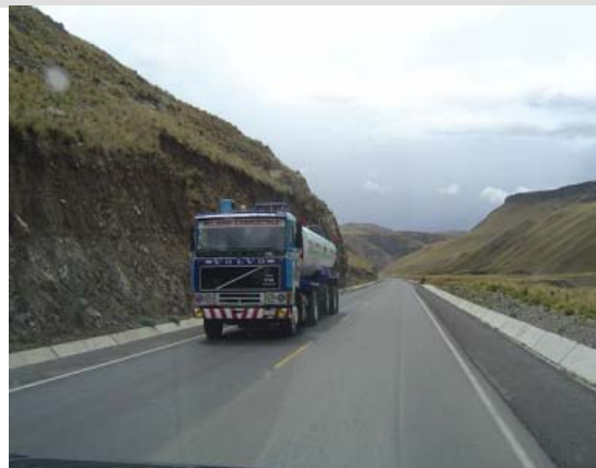
本事業により整備された国道
