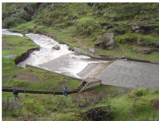
図-1 灌漑用水路取入れ口
