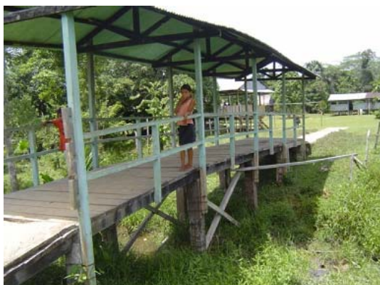
図-10 村落内の道路と橋梁(ロレト県)
