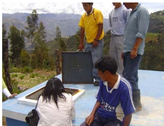
図-15 上水道貯水槽
