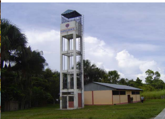
図-9 給水塔(ロレト県)
