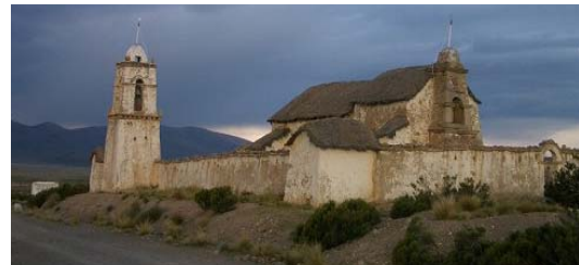
写真-11 保全工事が施されたカトリック教会 (サハ
