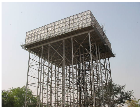
修復された高架貯水槽(タマレ)
