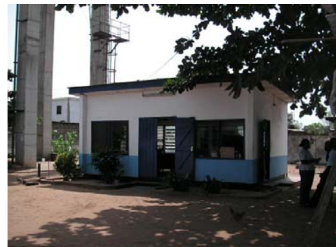
図 2 給水所事務所 ボルタ地域（アフラオ） （左は高架貯水槽の足）
