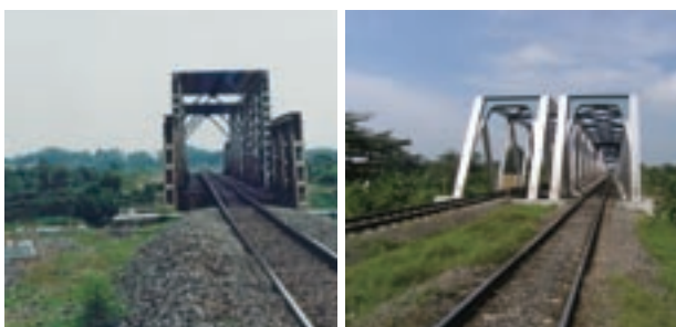
事業前の橋梁(左)。本事業にて橋梁修復が行われ、別途複線化も実施(右)。
