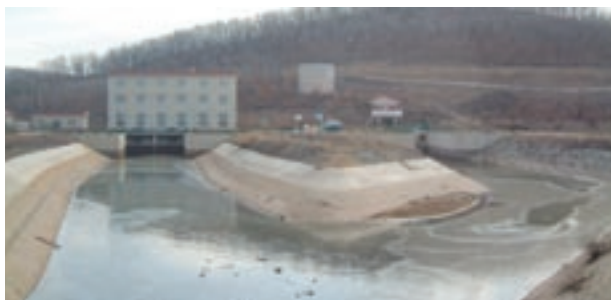
発電用水路(左)と灌漑用水路(右)
