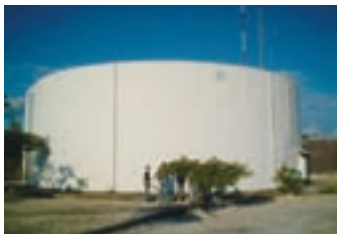
本事業により 整備された貯水槽
