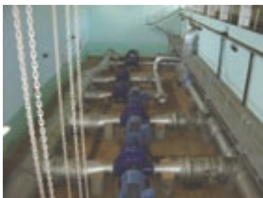
本事業において整備されたロマビタ排水センターの排水ポンプ
