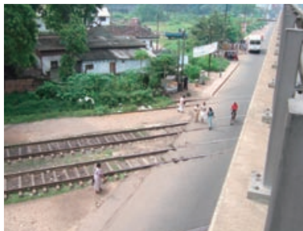
線路との陸橋
