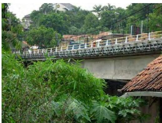
ジャワ島 西部ジャワ州 ササブシ橋
