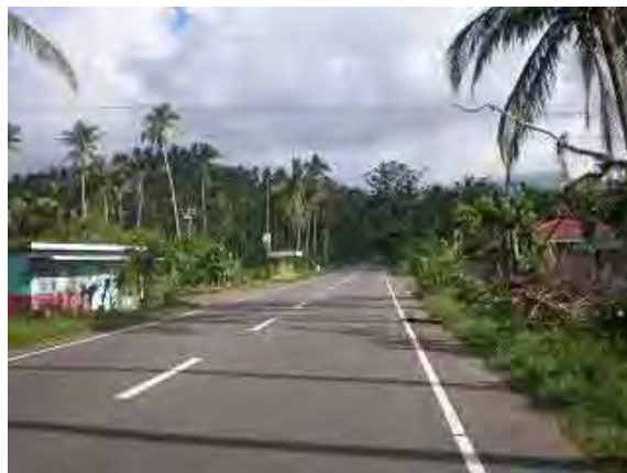
フェーズ2事業下の Daraga-Matnog 区間
