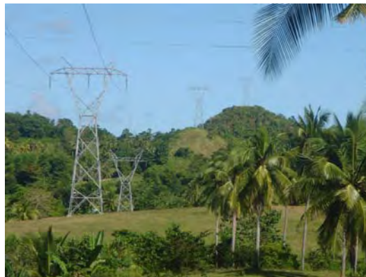
レイテ島側（マシン変電所～グアドルーペ CTS）送電線
