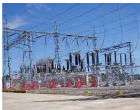
ウバイ変電所
