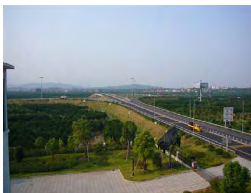
杭州～衢州高速道路衢州東インターチェンジ (終点)
