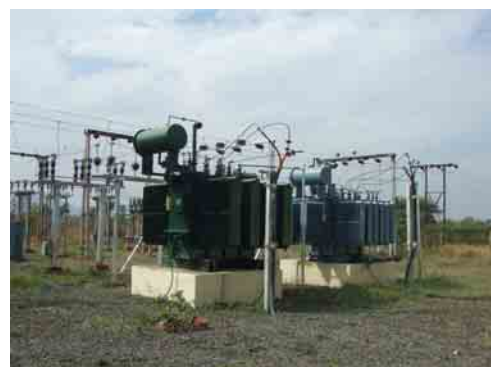
エローラ配電施設
