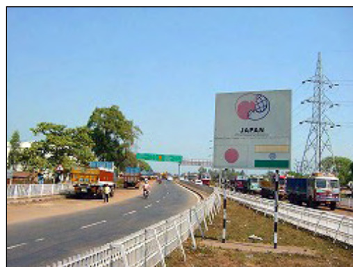
国道 5 号線 オリッサ州ジャガトプール
