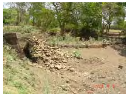
図9 破壊された流域対策施設
