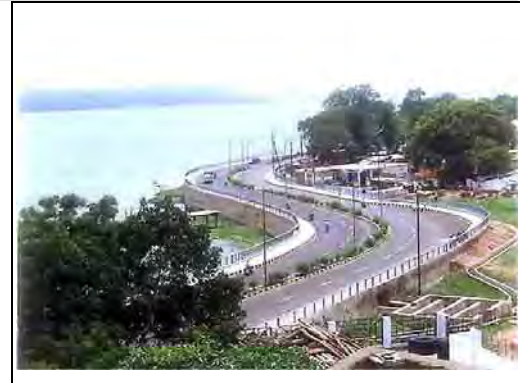
本事業で整備されたリンクロード
