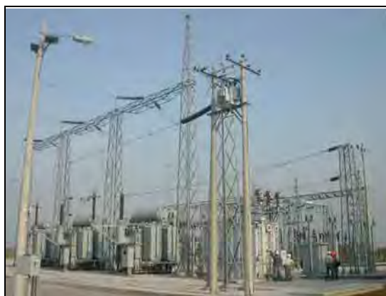
ドス・セリートス変電所
