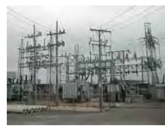
ミラグロ・スール変電所
