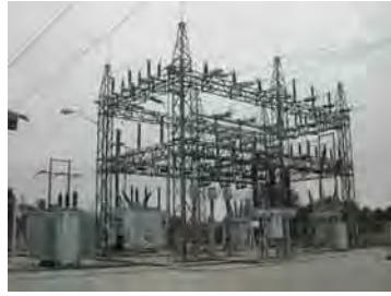
モンテロー変電所
