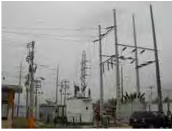
デウラン変電所
