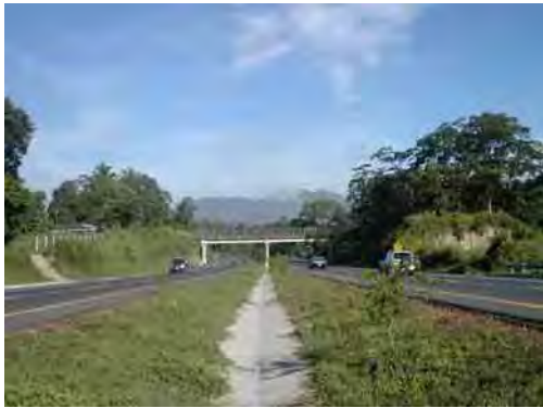
図9 日本式の排水性舗装技術が採用されている国道1号線
