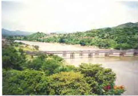
事業実施前の仮設橋梁
