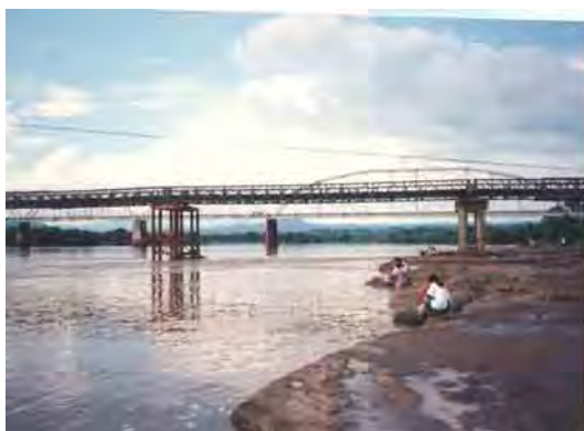
事業実施前の仮設橋梁
