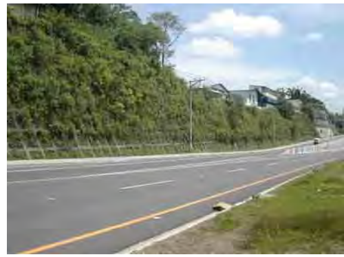
図10 首都北部幹線道路の修復で導入された環境に配慮したのり面
