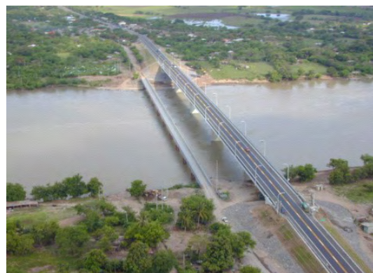
事業実施後の橋梁
