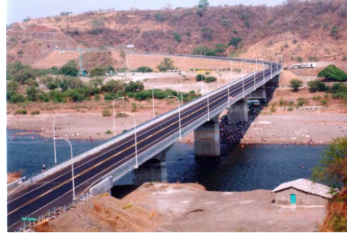
事業実施後の橋梁
