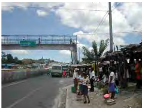
図5 安全確保のために設置された歩道橋とコンクリート防護柵
