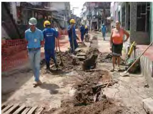
図 10 枝線暗渠の建設作業風景
