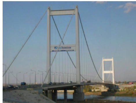
イルティシュ川吊橋
