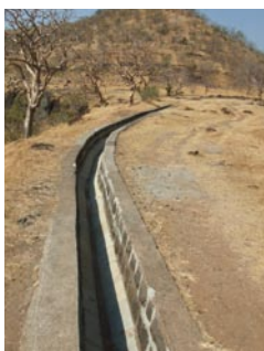
アジャンタ石窟上部の排水路
