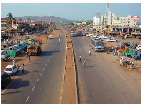
本事業にて 建設された道路 (チャンディコール)
