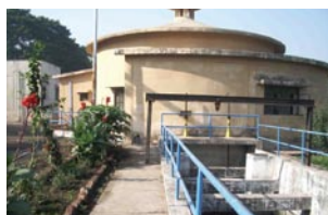
下水ポンプ場
