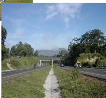
日本の技術を導入：周囲の自然環境および住環境への配慮をの排水性舗装技術(写真右)、および丘陵地を通過する道路のり面での落石防止、表面風化防止、景観保全を兼ねている土木技術(写真左)
