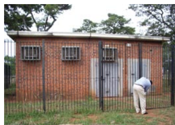
整備された交換局舎
