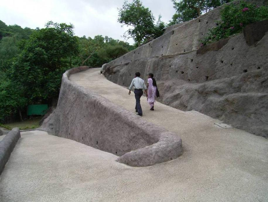
図13 新設斜路と擬岩風セメント吹き付け斜面
