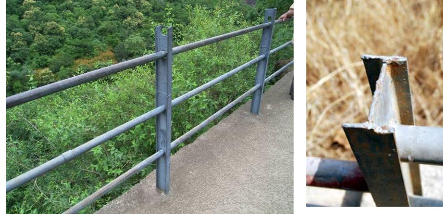
図14 H型鋼支柱によるガードレール
