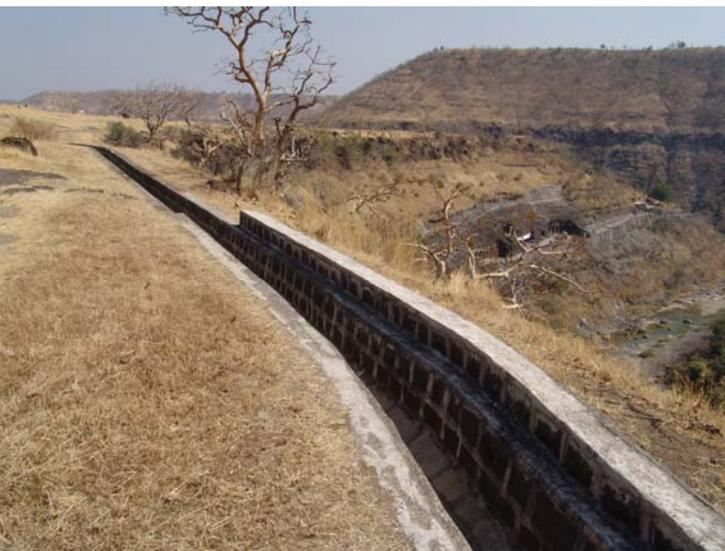
図21 石窟上部の平坦部に設けられている排水路
