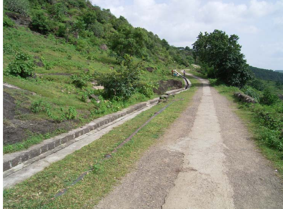
図49 排水路整備工事 第16石窟上部（左）、第1石窟上部から第16石窟脇へ導水する排水路
