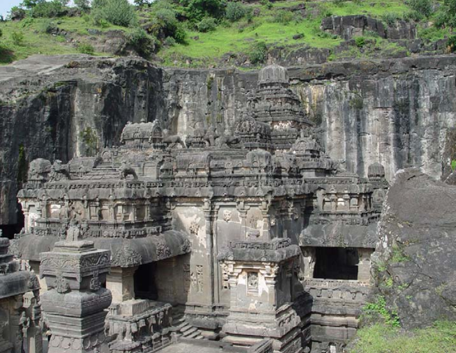
図55 クリーニング後の第16石窟(カイルーサ寺院)の正側面(左)と背側面(右) 2004年8月の時点。すでに大気汚染、微生物などにより石材表面の黒色化が進行している。
