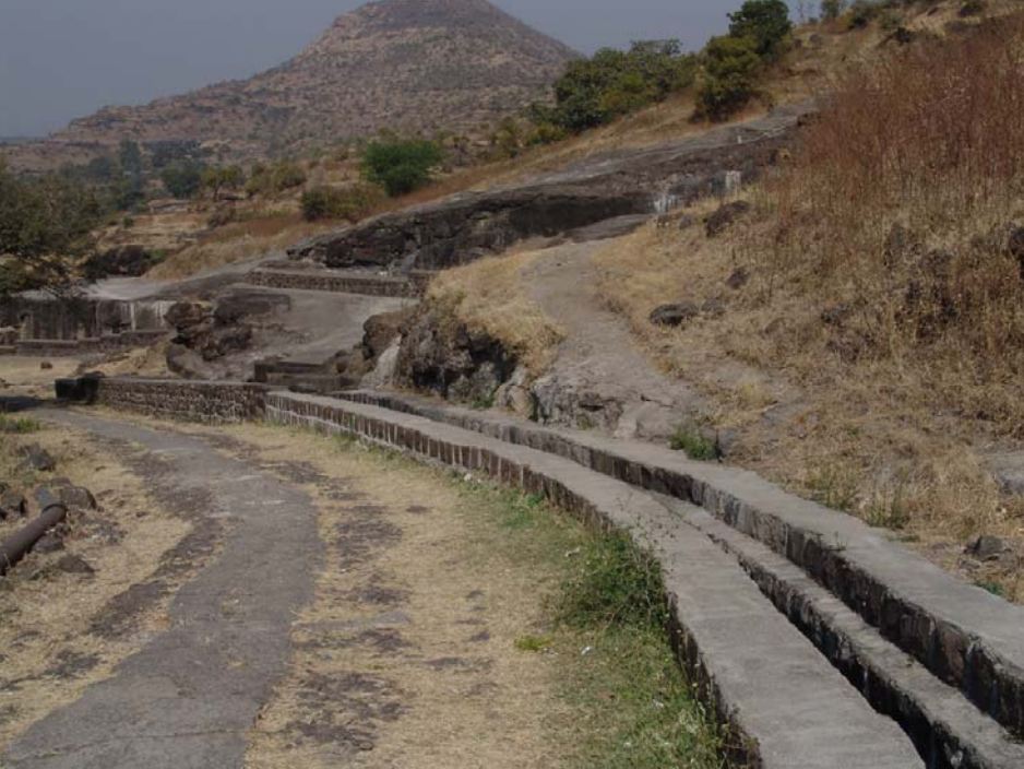
図49 排水路整備工事 第16石窟上部（左）、第1石窟上部から第16石窟脇へ導水する排水路
