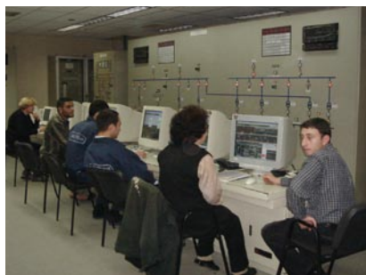
火力発電所のコントロール・ルームの様子（アゼルバイジャン）
