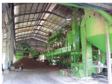
セクターローンで建設されたパームオイル工場(タイ)
