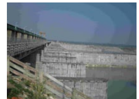
西ヤムナ運河水力発電事業(堰の下流側、先方に見えるガントリークレーンで各放水路の開閉を行う)
