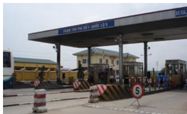
ベトナム「国道5号線改良事業」にて整備された料金所
