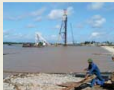
ハイフォン港での工事の様子
