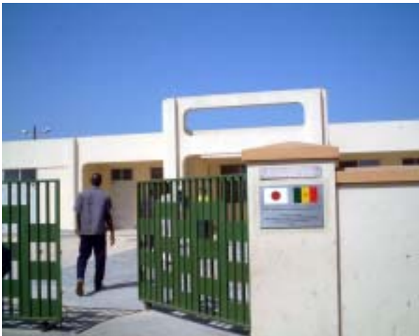
加工エリア事務所外観 (カヤール)
