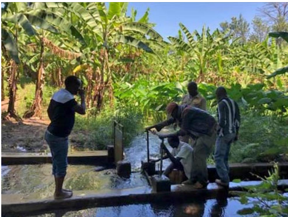
プロジェクトで建設した取水堰を操作する水利組合員（半乾燥地持続的小規模灌漑開発管理プロジェクト、ケニア）
