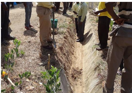
崩落したコンクリート板の除去
