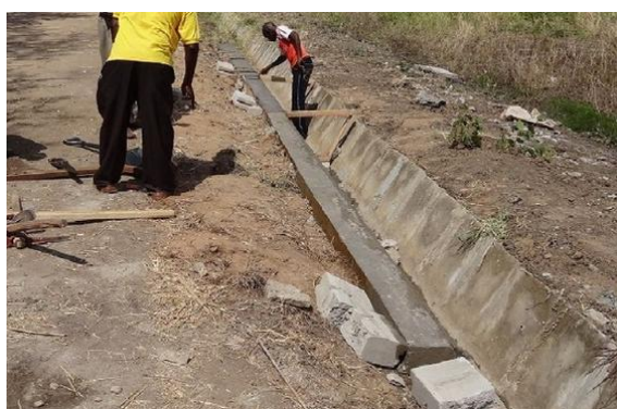
水路上端のキャッピング施工
