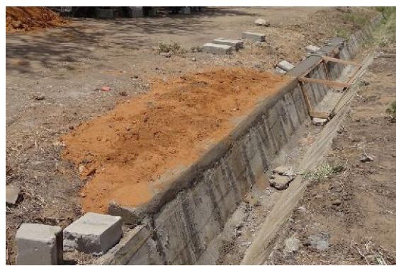
水路背面の埋め戻し
