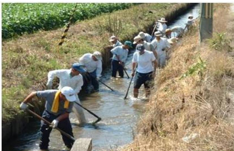
組合員による水路の保全管理作業
