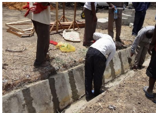
新たな板の敷設と目地のモルタル塗り
