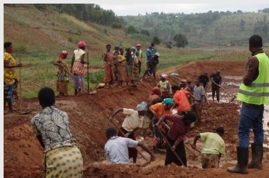
農民施工による夜間調整池建設 (ニャブヨゲラ灌漑地区)
