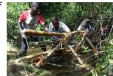
簡易取水堰の設置 (E-COBSI)
