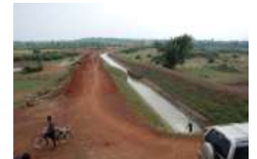
レンガリ灌漑事業で建設された水路
